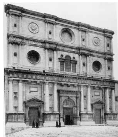
La facciata della basilica di San Bernardino all'Aquila e un articolo del quotidiano "Il Messaggero" sui lavori di restauro
