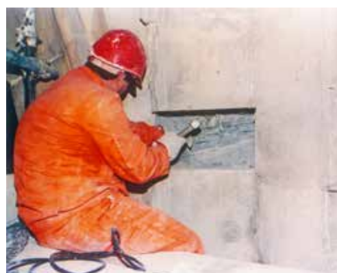
A sinistra veduta aerea del Duomo di Pavia. In alto, la visita delle autorità durante i lavori. In basso una fase dei lavori di consolidamento.
