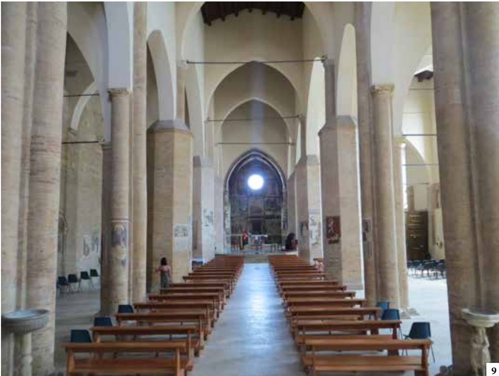
7. Vista di una navata laterale (post operam) 8. Il portale d'ingresso (post operam) 9. Vista della navata centrale (post operam)
