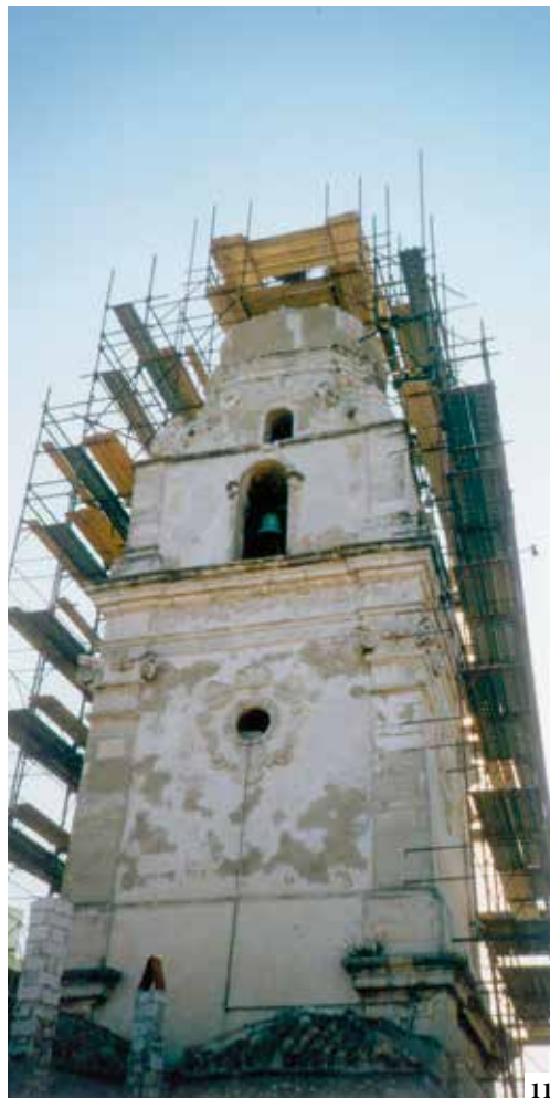
9. Armatura e rifacimento di cornici ai capitelli delle colonne
