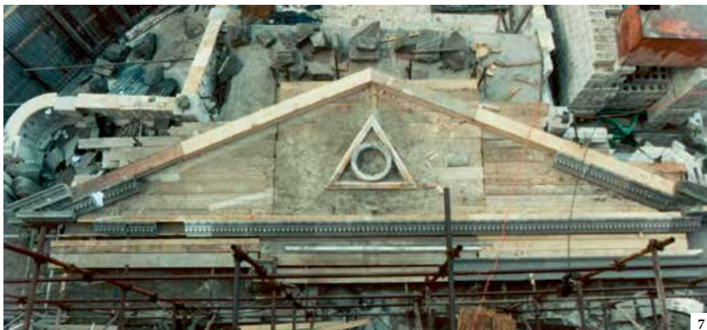
6. Particolare del campanile della fabbrica 7. Fase di rimontaggio del timpano della facciata
