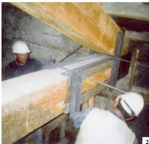
1-2-3. Fasi di recupero della struttura in legno del tetto con la preparazione e la messa in opera delle capriate in castagno
