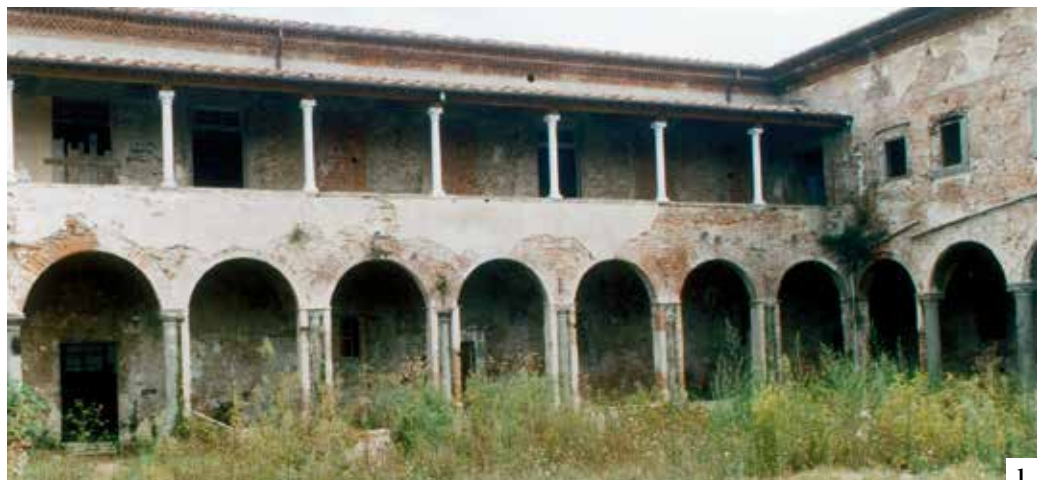
Dall'alto Prospetti di nord-est e di sud-ovest del chiostro. 1. Veduta del chiostro (ante operam)
