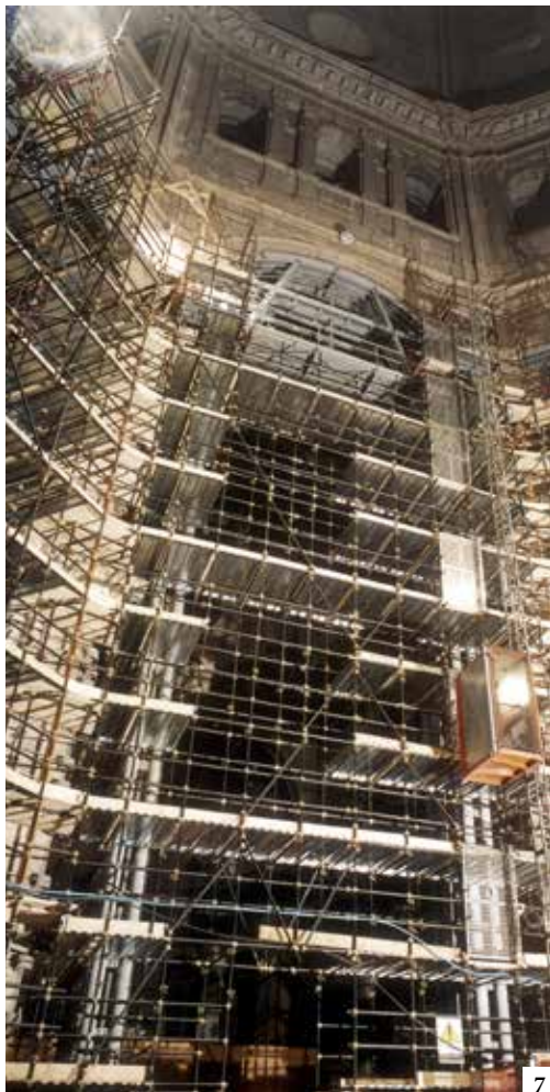
7. Veduta dei ponteggi all'interno dell'ottagono della cupola
