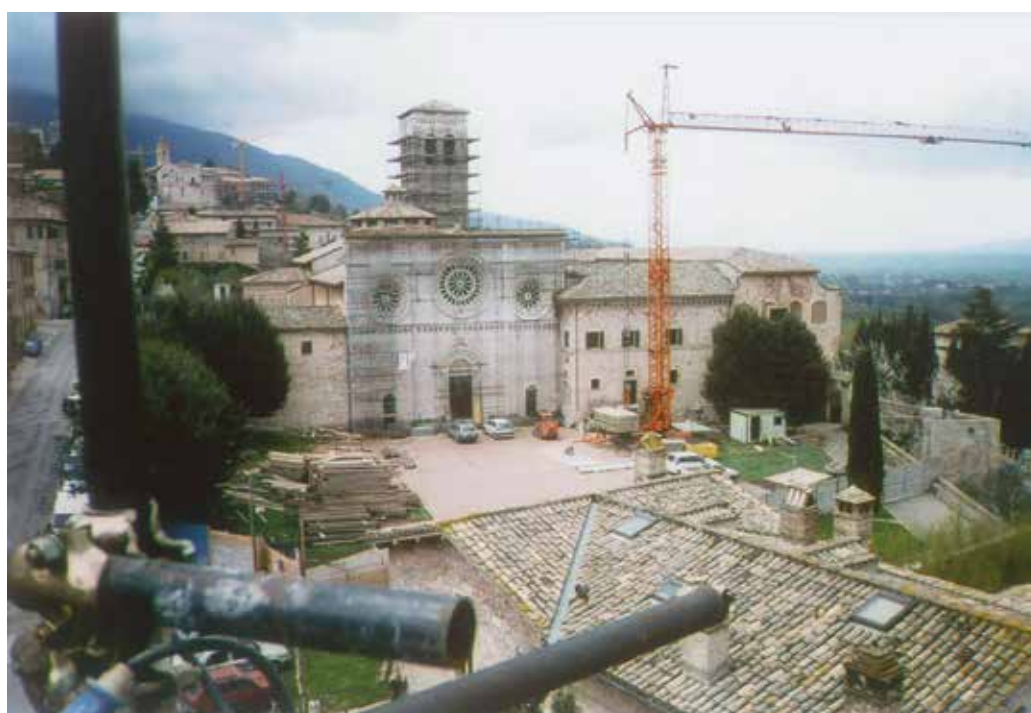
In alto. Prospetto della facciata principale del complesso Al centro. Prospetto posteriore del complesso In basso. Veduta generale del complesso in fase di restauro
