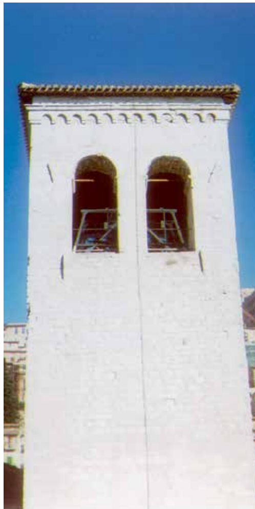
A sinistra. Particolari del rosone e del portale A destra. Il campanile dopo le opere di restauro
