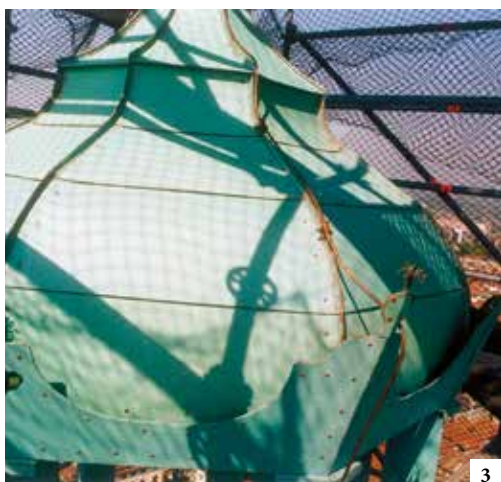
1-2-3-4. Fasi di restauro del cupolino con smontaggio dell'esistente in ferro, legno e rame e nuovo rivestimento in legno
