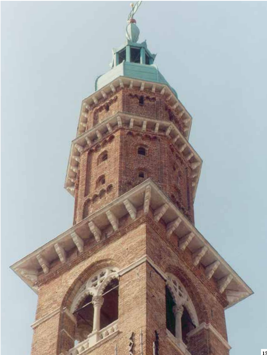
13-14. Fasi di pulizia e di restauro degli elementi in pietra 15. La torre (post operam)
