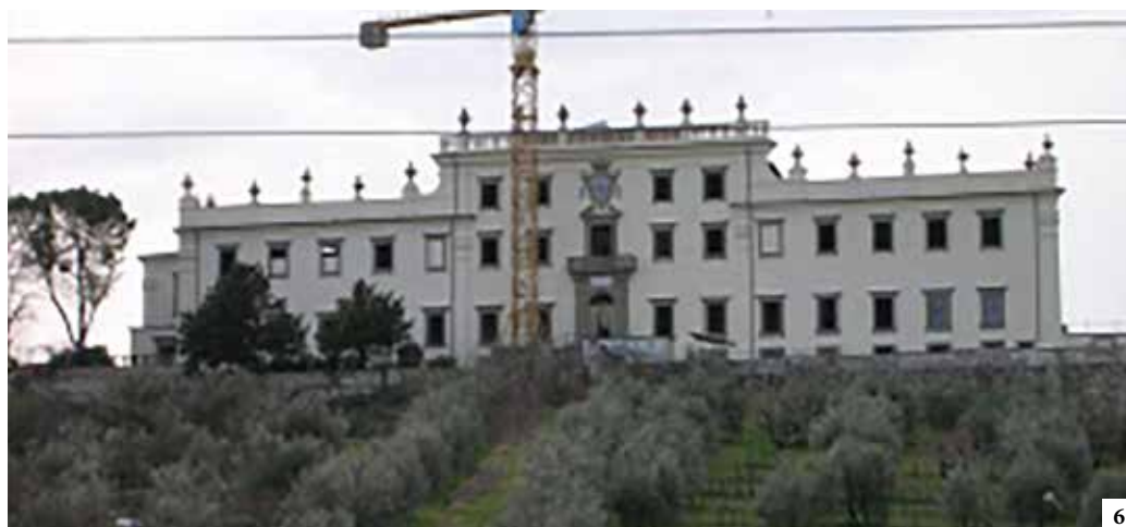
6. Prospetto della villa visto dalla Statale
