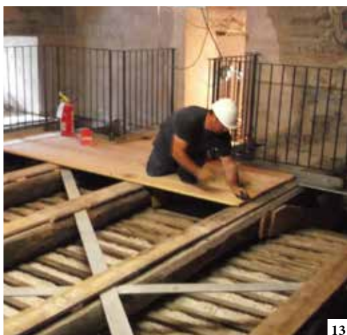
13. Inserimento del tavolato durante i lavori di consolidamento del solaio 14. Realizzazione della nuova copertura in legno lamellare
