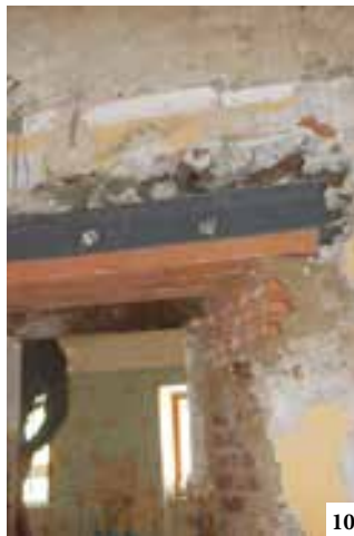
Dettaglio del consolidamento della volta
